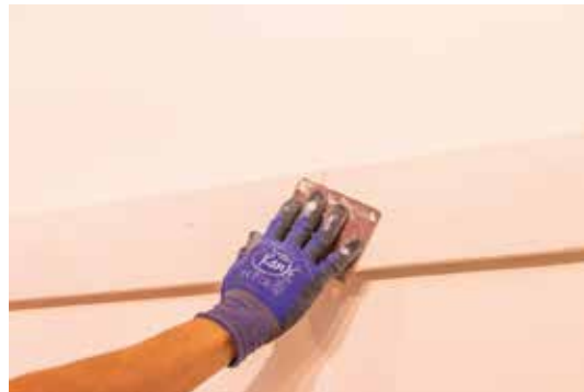
8 - Se serve, carteggiare sino ad ottenere una superficie uniforme
