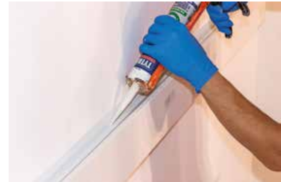
6 - Applicare del silicone acrilico tra profilo e supporto
