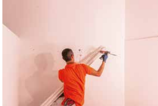
2 - Cablare e applicare l'adesivo su tutta la lunghezza del profilo
