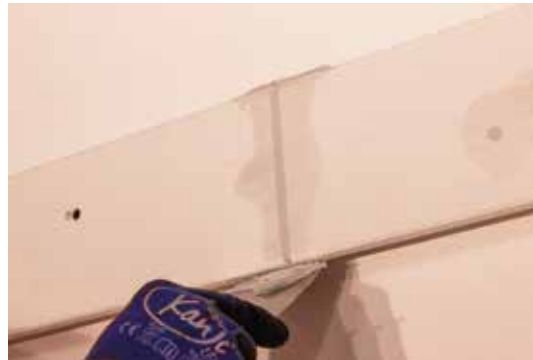
5 - Stuccare le giunzioni e dove necessario
