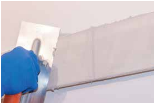
7 - Procedere con la rasatura a stucco o con la texture desiderata
