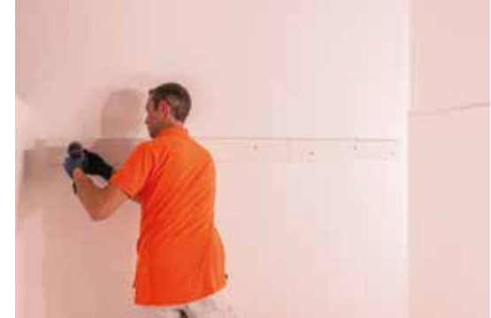
3 - Fissare meccanicamente con viti da cartongesso
