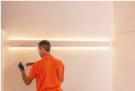
4 - Collaudare i segmenti luminosi e applicare l'adesivo sui terminali
